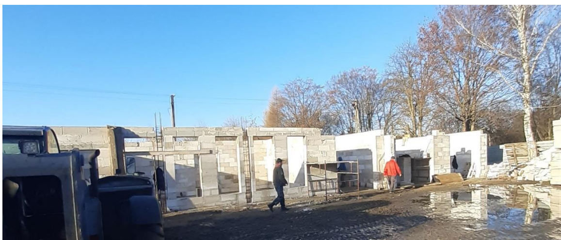
Budowa budynku GOPS-u
