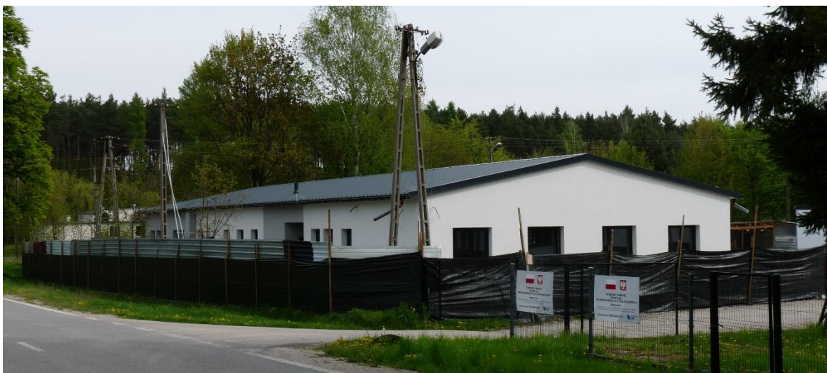
Budowa budynku GOPS-u
