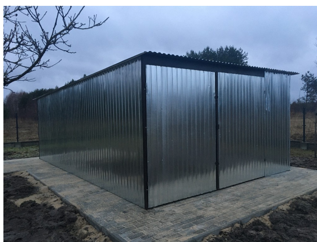
Zakup budynku gospodarczego blaszanego wraz z przygotowaniem podłoża i dokumentacją w miejscowości Podwódka
