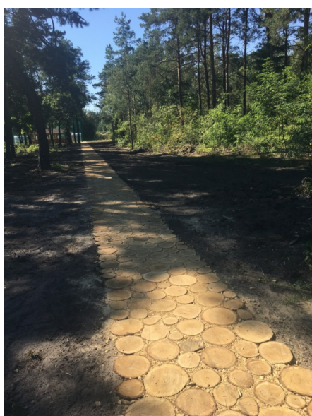
Utwardzenie terenu rekreacyjnego w miejscowości Nowy Janów
