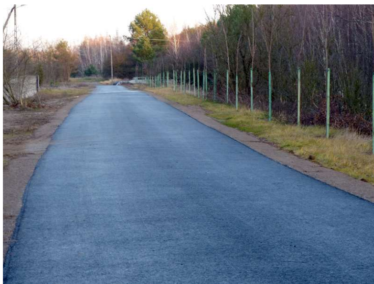
4. Przebudowa drogi w Kuźnicy Kaszewskiej
