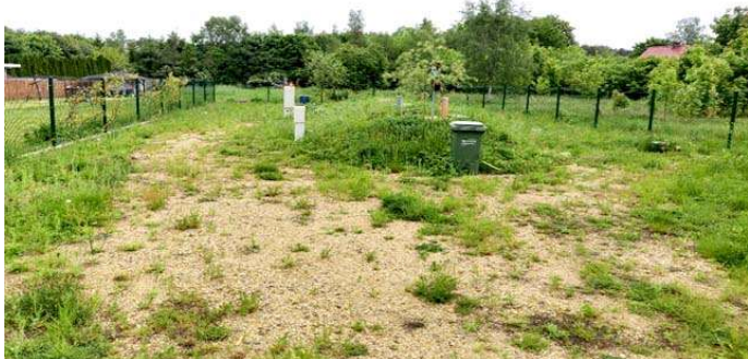
Oczyszczalnia ścieków przy blokach Wspólnoty Mieszkaniowej w Klukach
