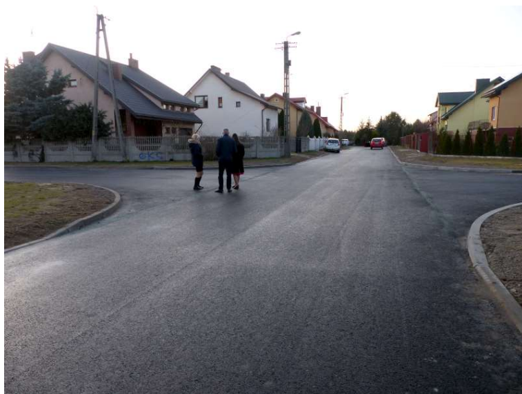
3. Przebudowa dróg na Osiedlu Leśnym w Klukach (ul. Jesionowa, ul. Spacerowa)
