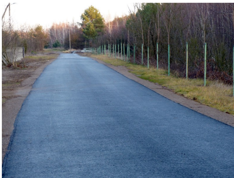
4. Przebudowa drogi w Kuźnicy Kaszewskiej
